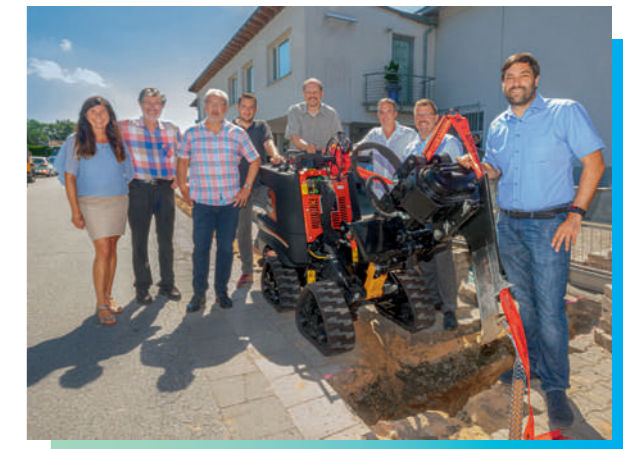
Die GGEW AG sorgt mit dem Glasfaserausbau – wie hier in Bickenbach – für High Speed Internet in der Region
